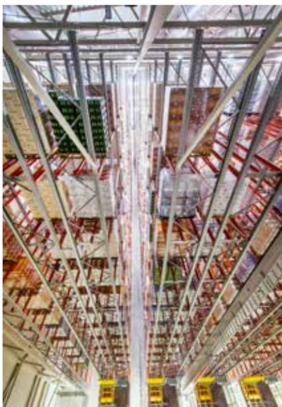
Automatisierte Paletten Hochregallager sind überall dort sinnvoll, wo kürzeste Zugriffszeiten bei gleichzeitig hoher Warenverfügbarkeit und Umschlagshäufigkeit gefordert sind. Dexion bietet hierfür das geeignete Regalsystem inklusive des Stahlbaus für die Bereitstellungszone. Automatische Regalbediengeräte und Fördertechnik sorgen für einen schnellen fehlerfreien Wareneinsatz und Materialfluss. Die Regalbediengeräte operieren bis Regalhöhen von 25 m und bewegen ca. 200 Paletten pro Stunde.
